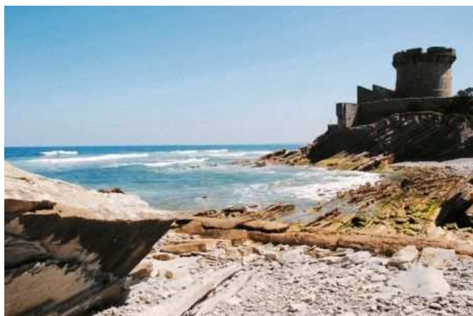
L'érosion a fini par provoquer un effondrement de la falaise près du fort. PHOTO P. P.
